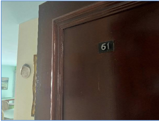
Foto 1 – Porta de entrada do imóvel
