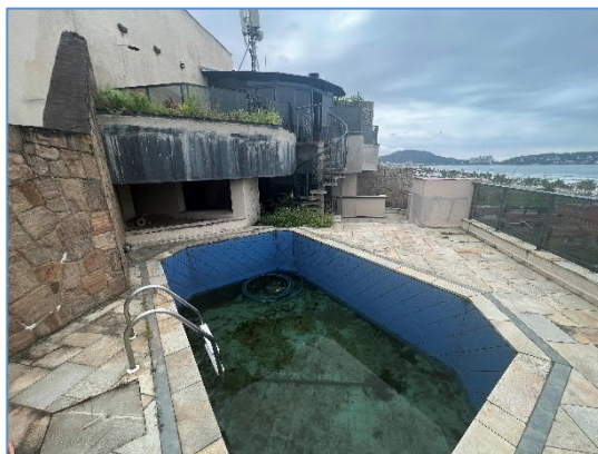
Foto 14 – Área externa da piscina
