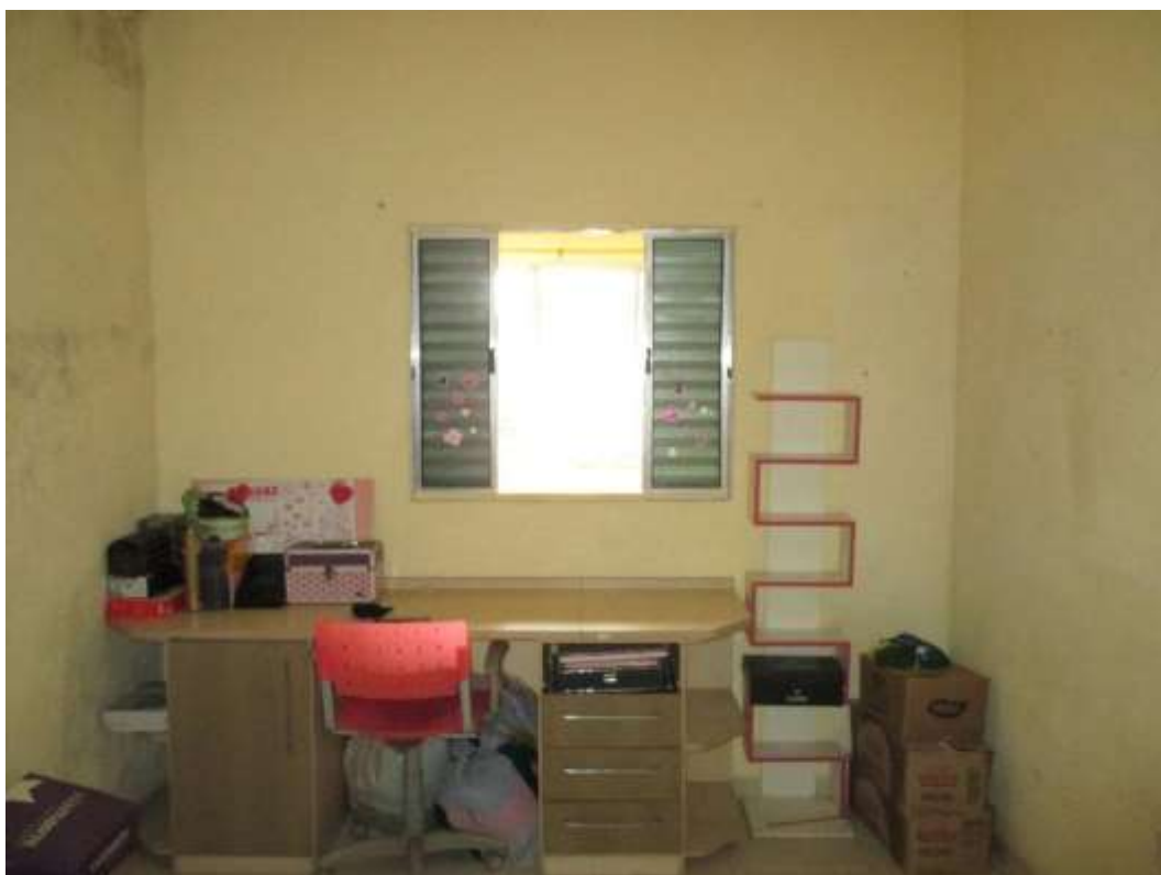
Esquadria de alumínio do dormitório.
