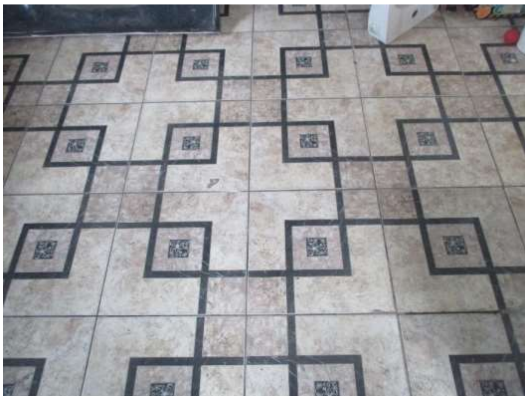
Piso cerâmico em vista aproximada.
