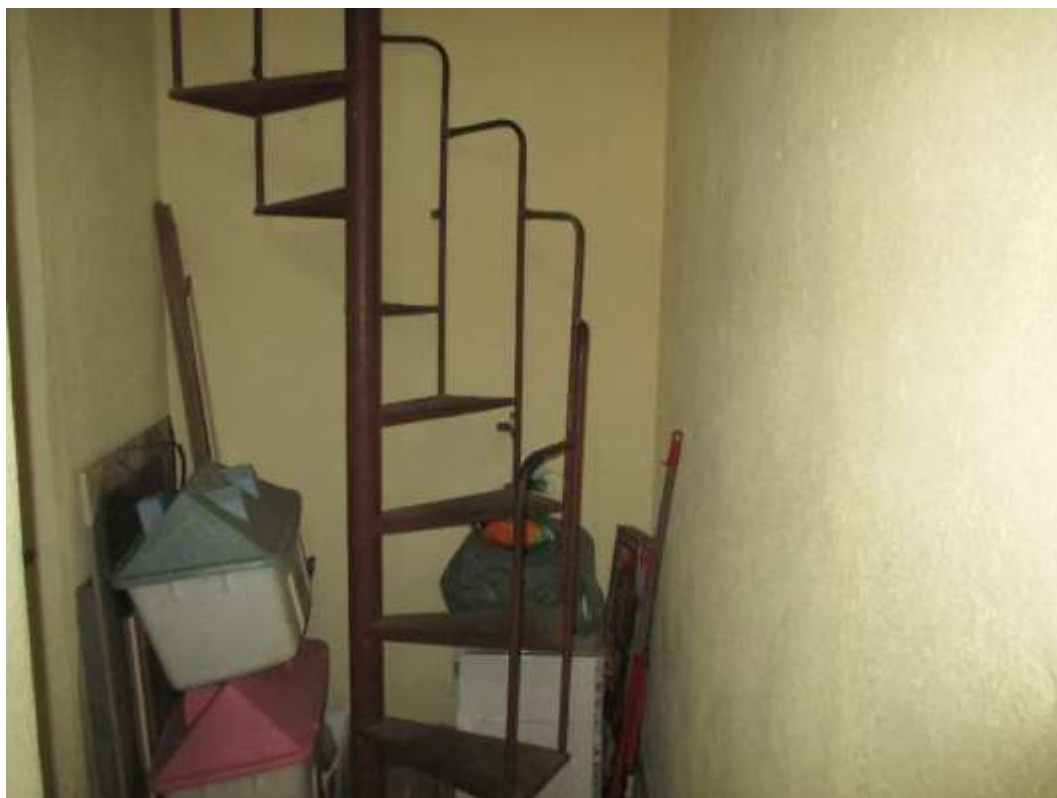
Escada de acesso ao pavimento superior.
