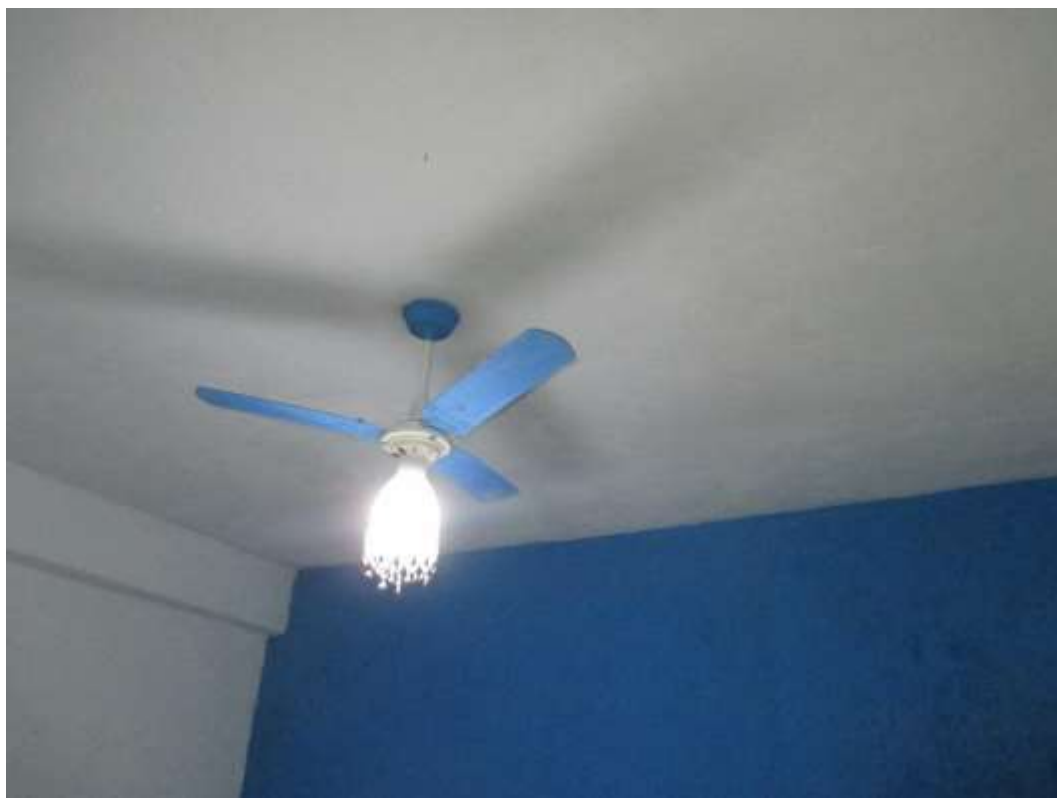
Laje sobre a sala de estar.
