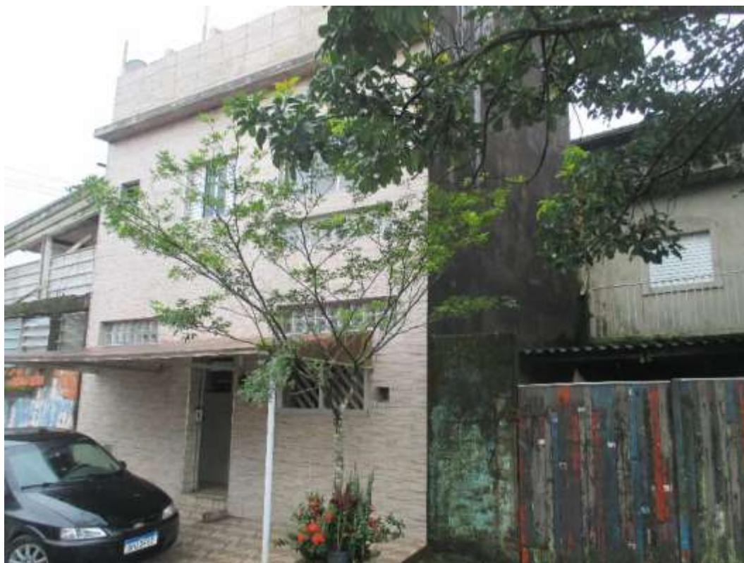
Face oposta da fachada.
