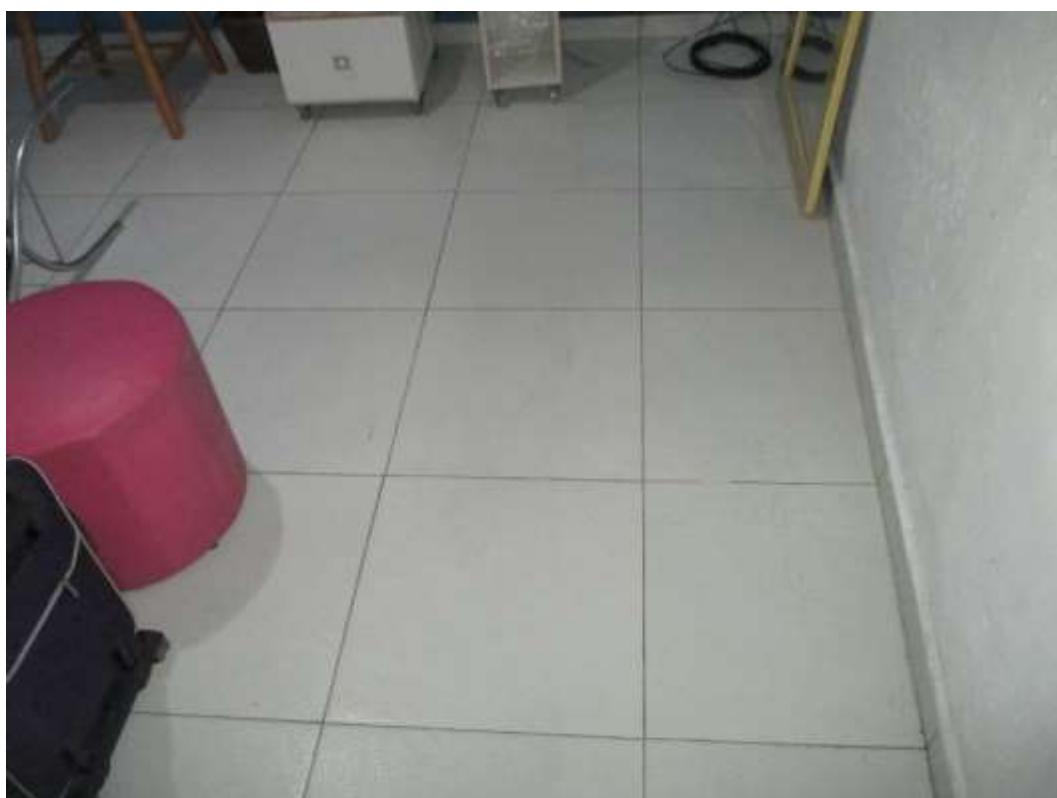
Piso cerâmico da sala de estar.
