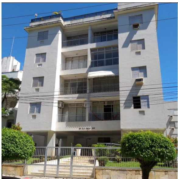
Tomada mostrando a fachada frontal do Condomínio Edifício Vila Velha – R. França Pinto, 245, bairro Enseada, município de Guarujá-SP.
