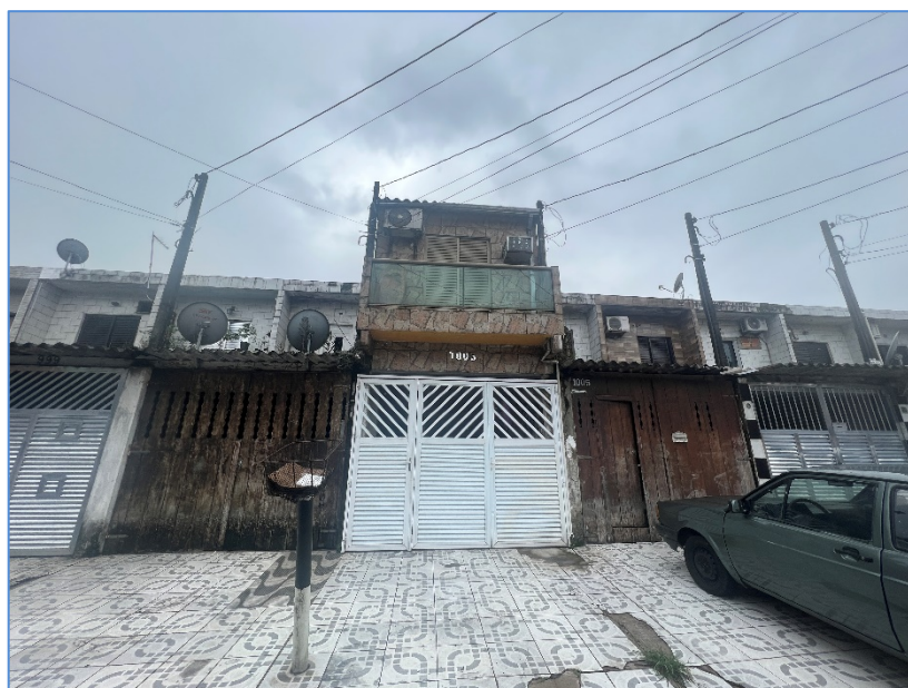
Foto 2 – Vista frontal do imóvel avaliando. Notar divergência de padrão com as outras casas geminadas e vizinhas, pertencente ao mesmo Condomínio.
