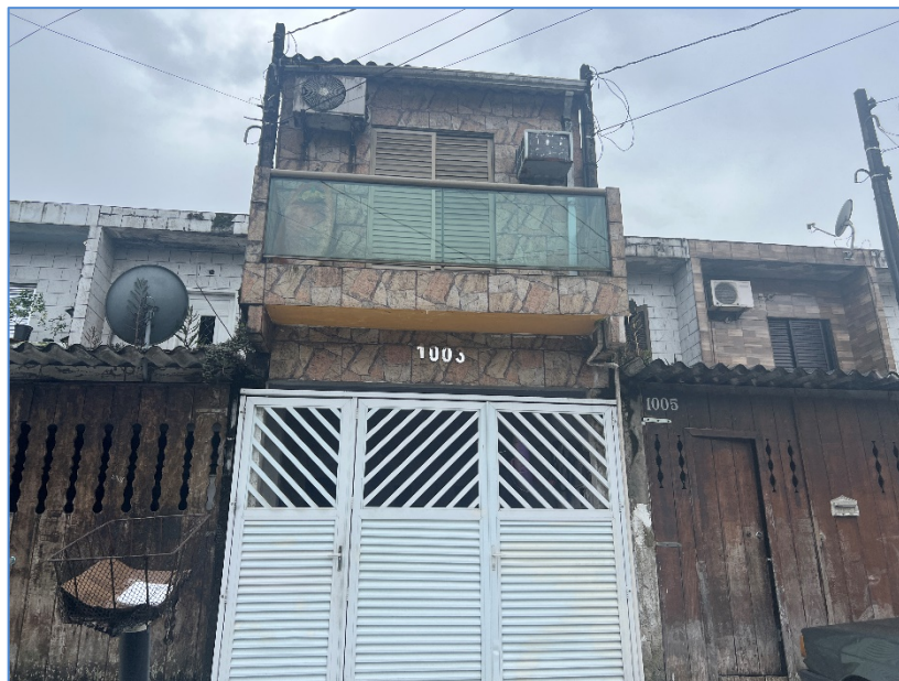
Foto 1 – Vista frontal do imóvel. Notar ampliação da laje do pavimento superior, que cobriu o recuo frontal e transformou-o em garagem coberta.
