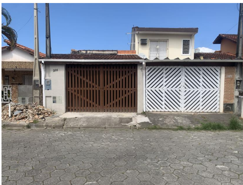
Foto 09 - Imóvel avaliando e imóvel vizinho
