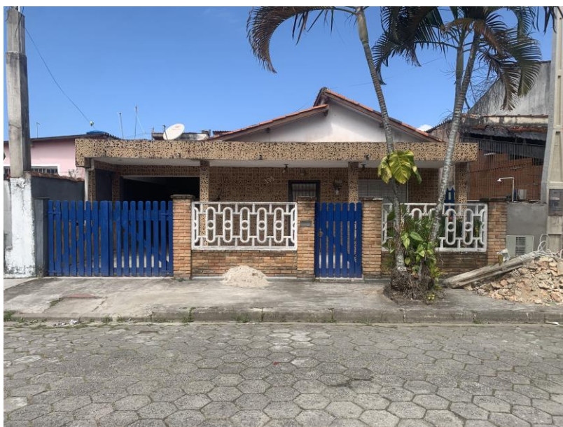
Foto 12 - Imóvel vizinho lado esquerdo
