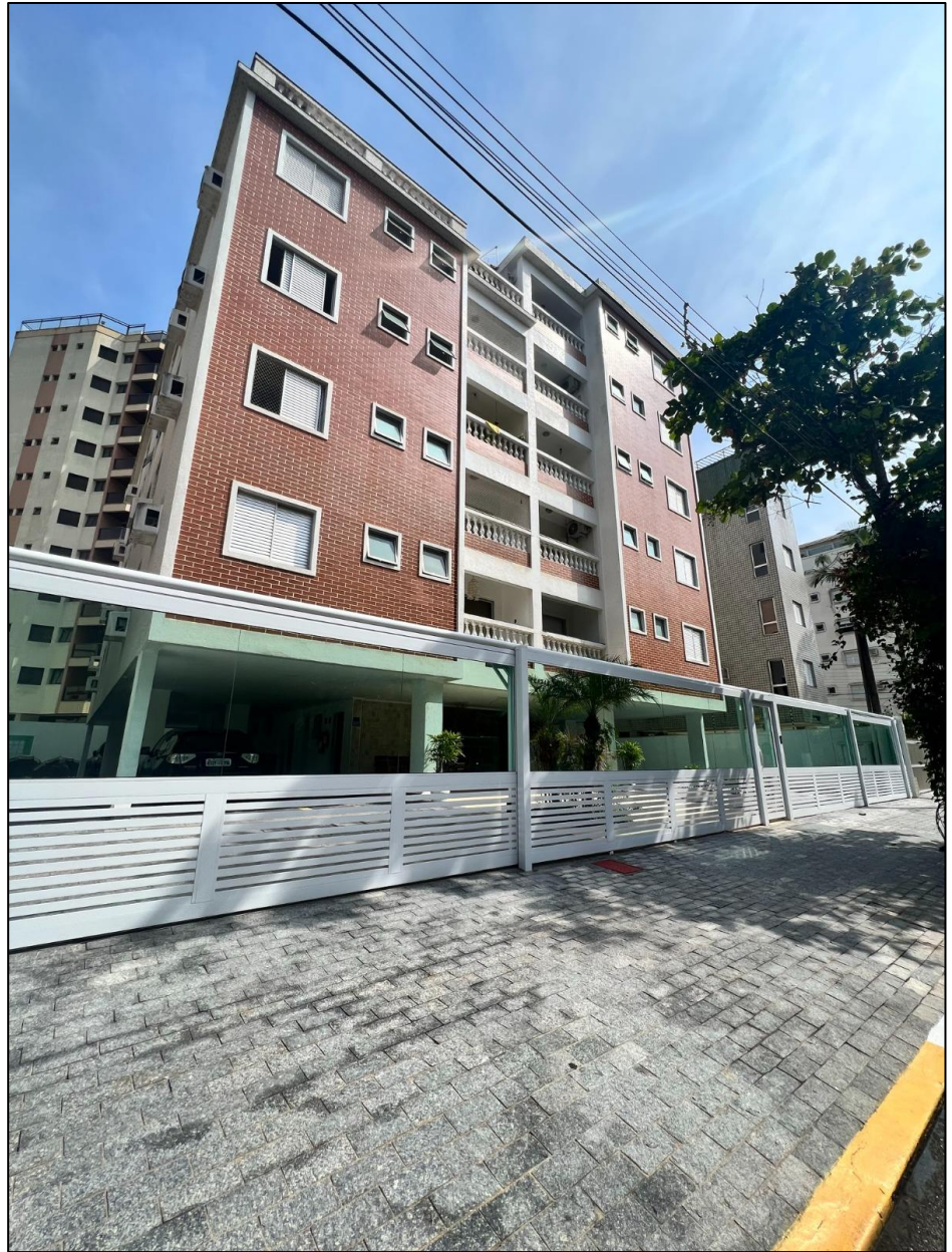
Vista geral da fachada do edifício.
