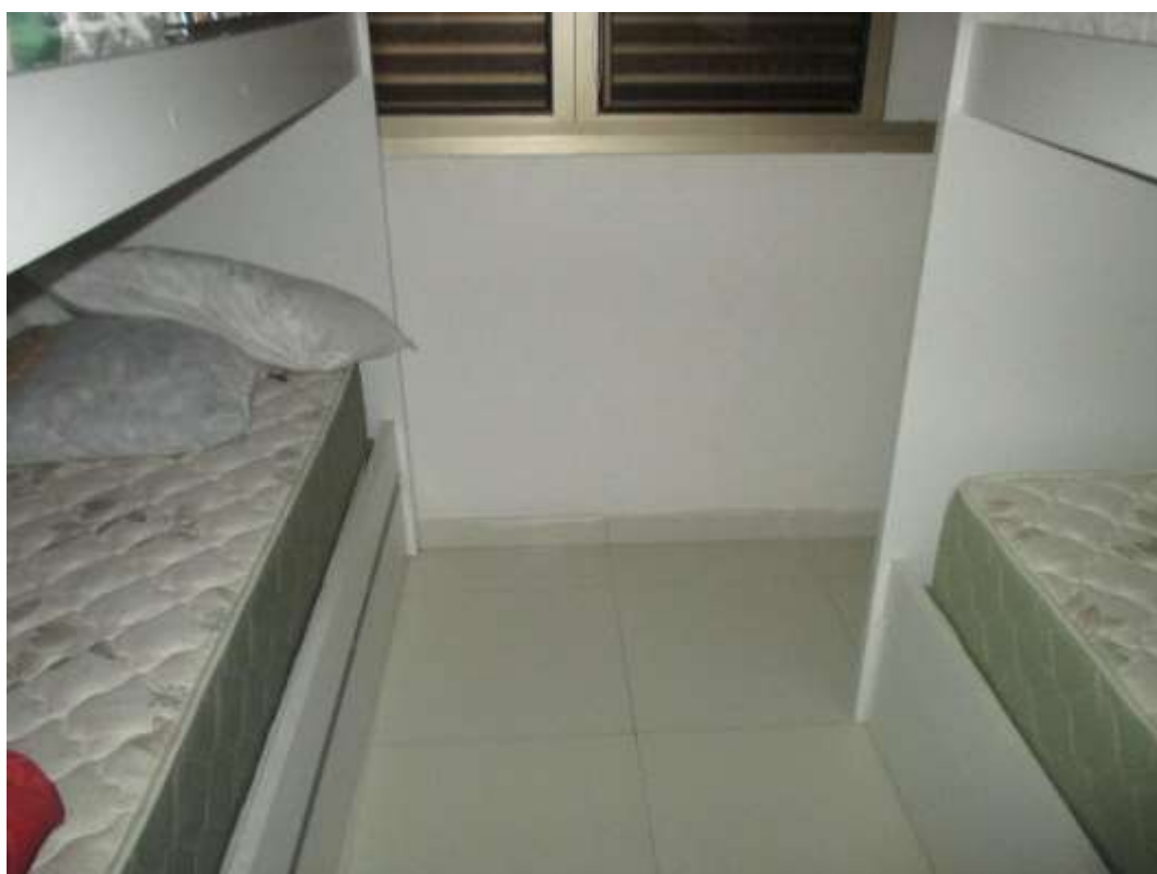
Detalhe do caixilho e revestimento cerâmico do piso.
