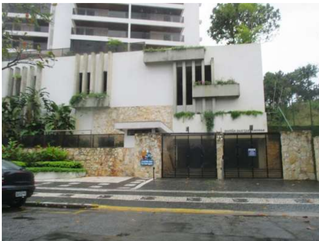
Entrada da garagem e portaria do condomínio.
