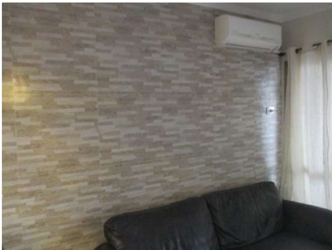
Revestimento da parede e equipamento de ar condicionado.
