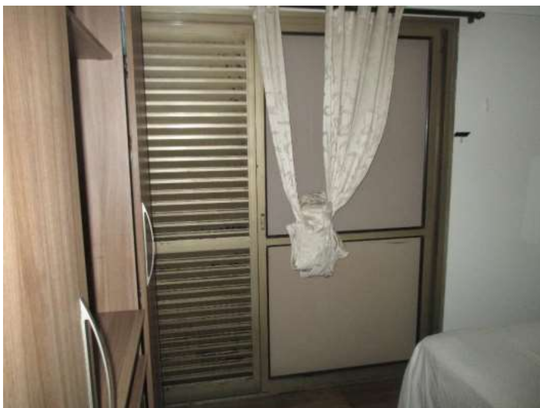
Detalhe do caixilho em alumínio.
