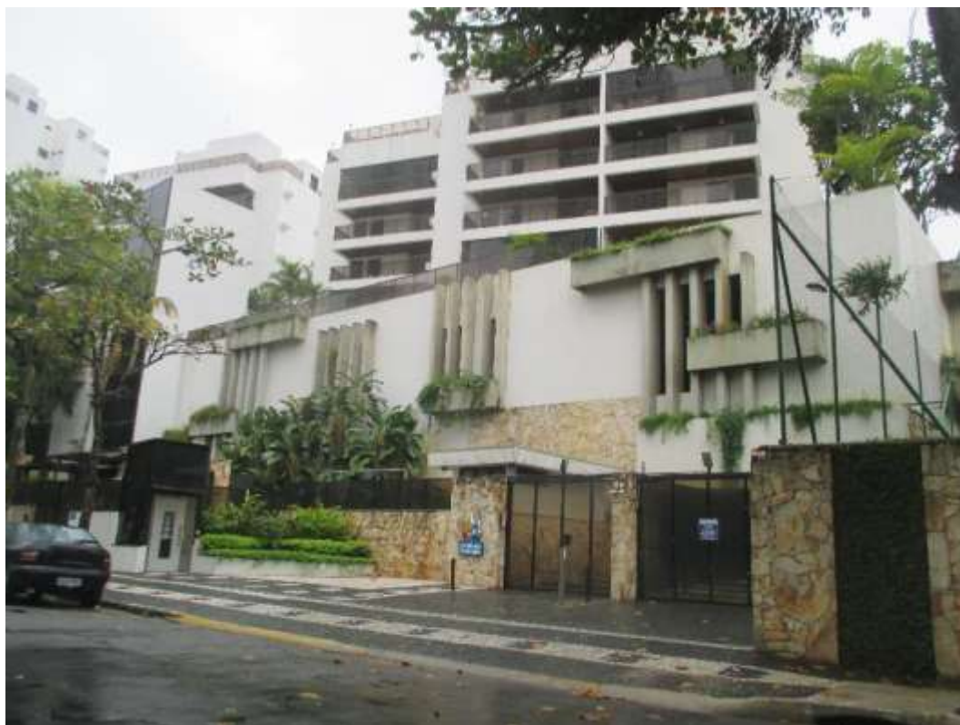
Mais uma tomada geral do condomínio pela Rua Caminho das Tartarugas.
