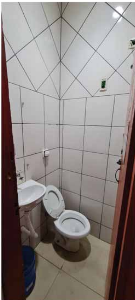
FOTO (11) Loja - banheiro 1.jpg
