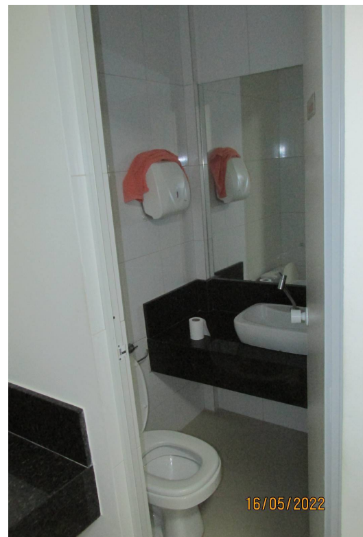
Foto 54) Vista de área com pia lavatório e dois banheiros, existente ao lado da cozinha. Observar acabamento e pia lavatório com tampo em granito e cuba de sobrepor.
