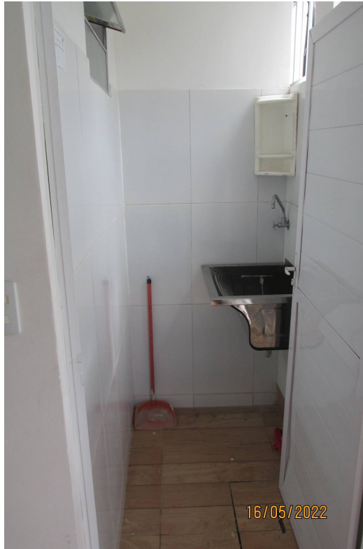
Foto 10) Vista da área de serviço de uso comum, com acesso pelo corredor de entrada. Observar piso cerâmico, paredes com azulejos até cerca de 2,00 metros e tanque para roupas em aço inoxidável.
