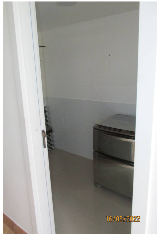
Foto 11) Vista de dependência existente lateralmente à área de serviço apresentada na foto anterior. Observar piso em porcelanato, parede com barra impermeável, o restante e teto a látex sobre massa corrida.
