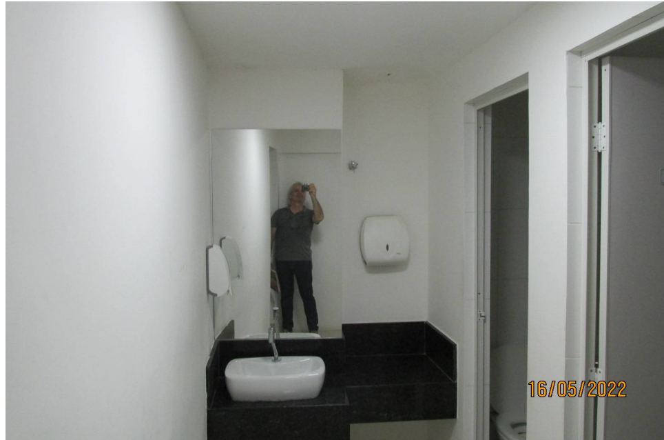
Foto 54) Vista de área com pia lavatório e dois banheiros, existente ao lado da cozinha. Observar acabamento e pia lavatório com tampo em granito e cuba de sobrepor.
