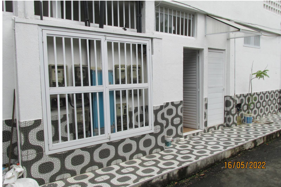
Foto 26) Vista do nicho onde se localizam os relógios medidores de energia e da porta de entrada do terceiro apartamento. Observar porta em alumínio na cor branca e vão acima da porta com caixilho, vidro e gradil.
