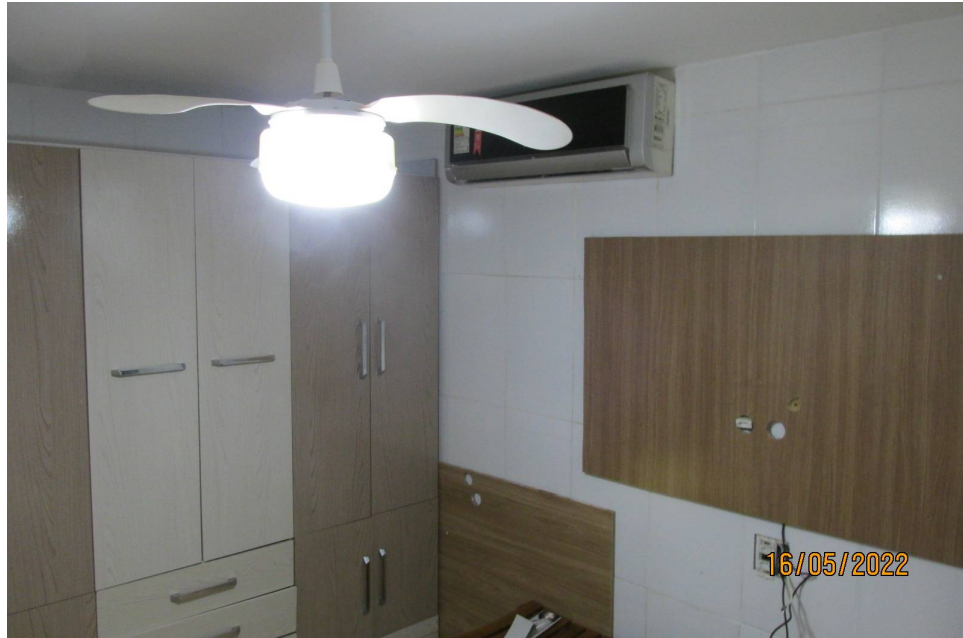
Foto 24) Vista do dormitório. Observar acabamento e aparelho de ar condicionado. A dependência não possui abertura destinada a ventilação e iluminação natural.
