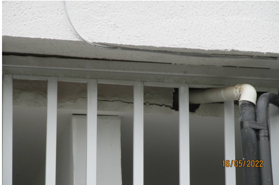
Foto 8) Detalhe vão sem caixilho onde se observa destaque do forro em relação ao acabamento lateral e parede em "dry wall" descolada do forro.
