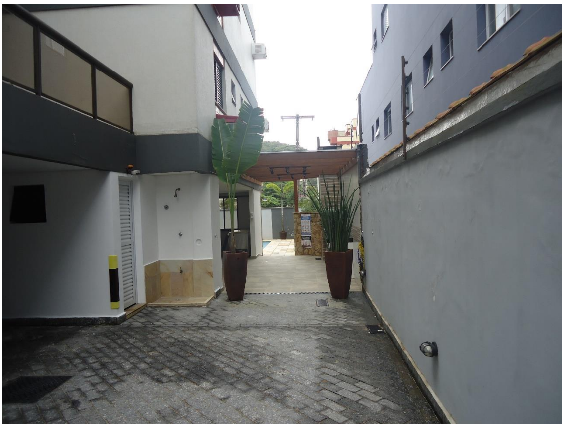
Corredor lateral (recuo) – acesso à área da churrasqueira.
