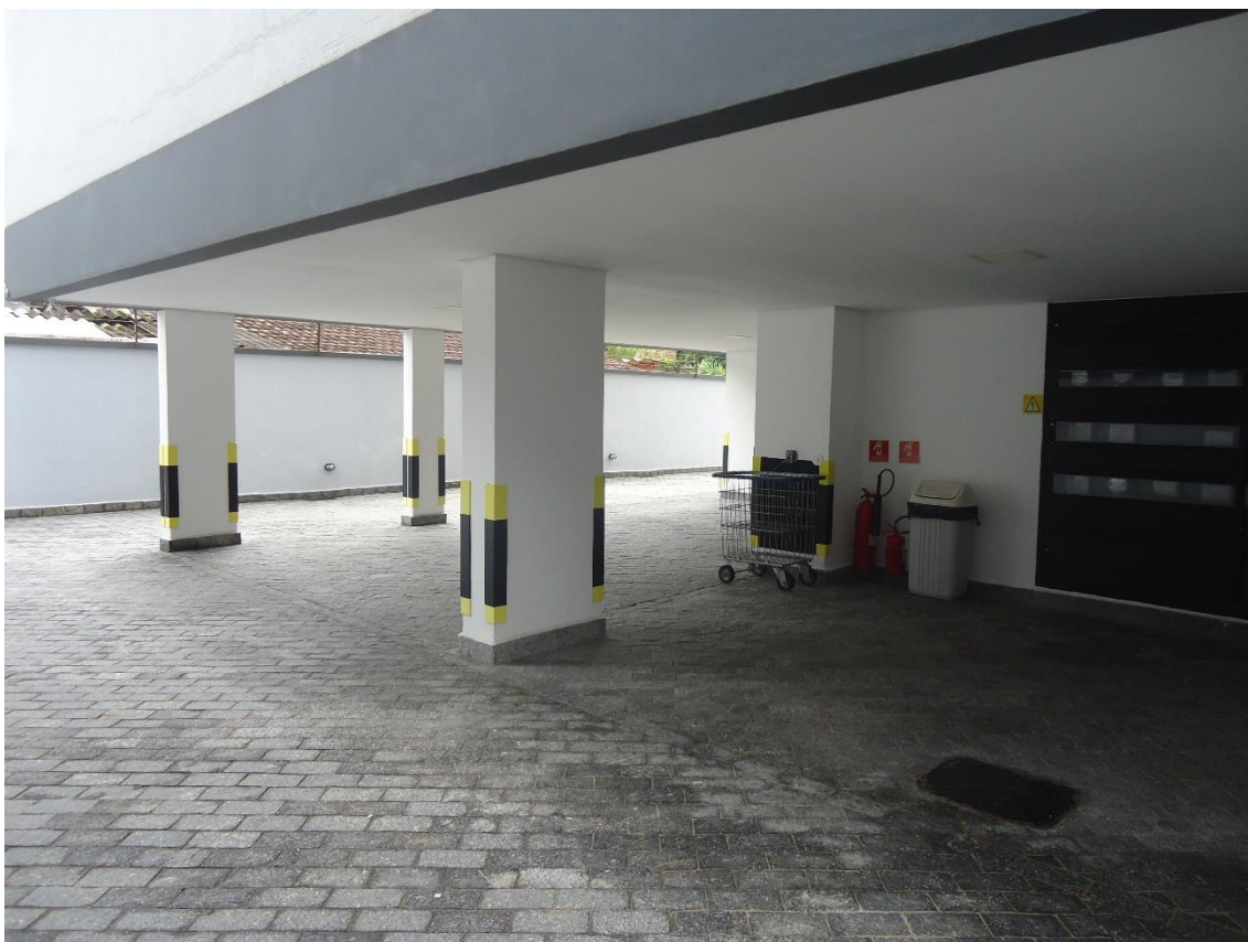
Visão geral do pavimento térreo destinado a vagas de garagem.
