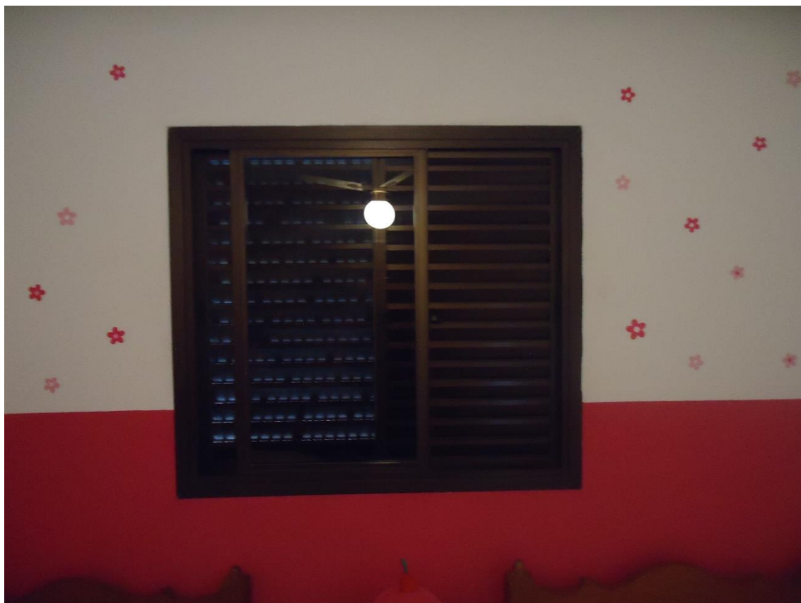
Caixilho em alumínio.
