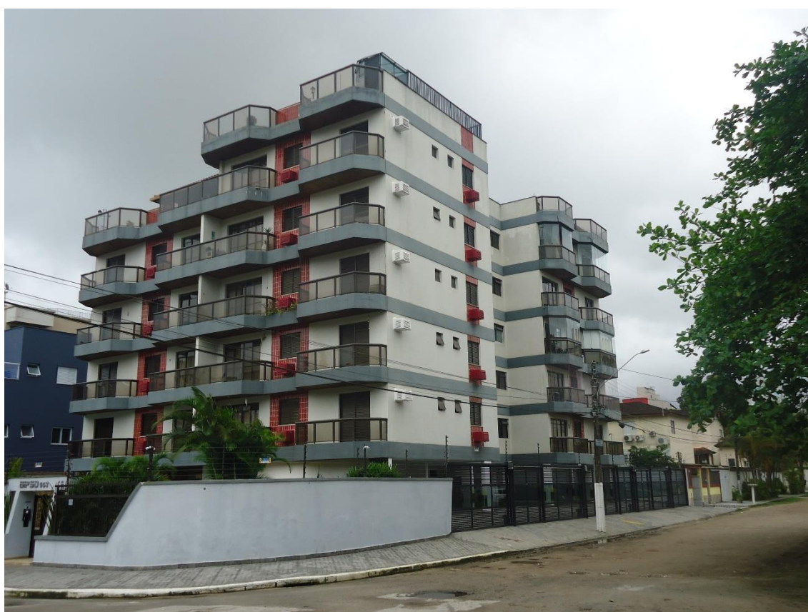
Condomínio observado a partir da esquina entre a Rua São Paulo e Rua Flávio Humberto Ribizi.
