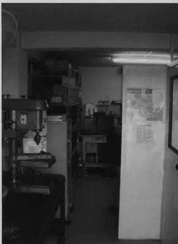
VISTA DA OFICINA DA MANUTENÇÃO ELÉTRICA.
