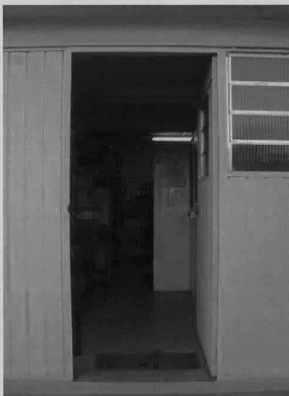
VISTA DA ENTRADA DA OFICINA DE MANUTENÇÃO ELÉTRICA.
