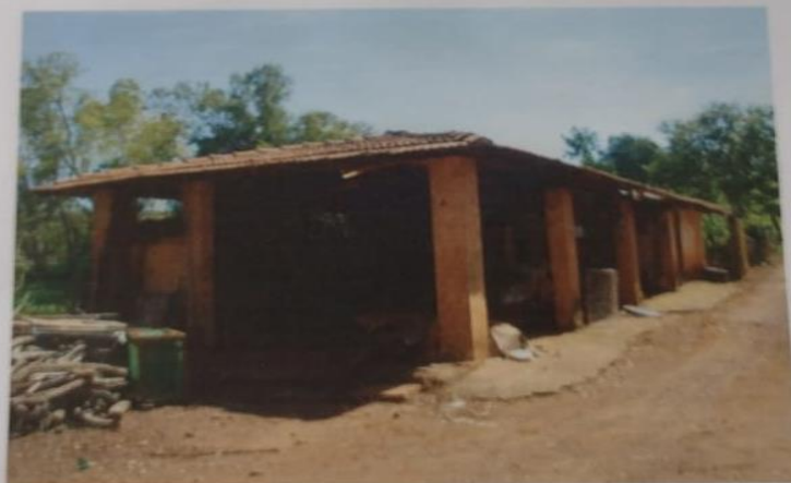
FOTO 14 – Vista de outra construção existente no imóvel em questão.
