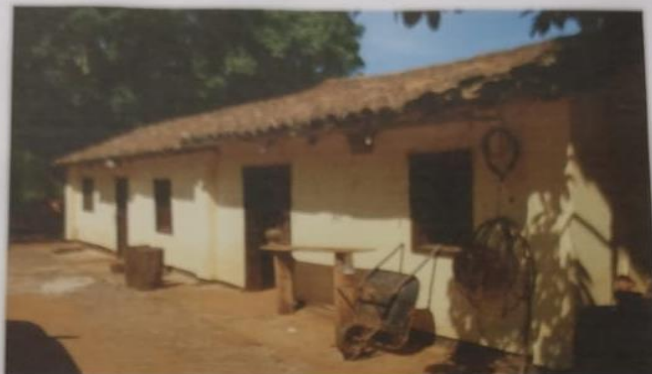
FOTO 13 – Vista de uma construção existente no imóvel em questão.
