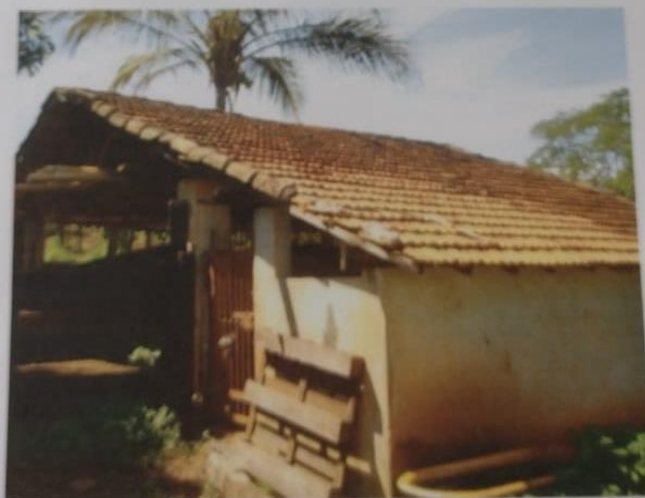
FOTO 16 – Vista de outra construção existente no imóvel em questão.
