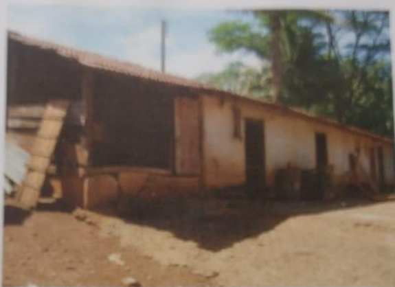
FOTO 15 – Vista de outra construção existente no imóvel em questão.
