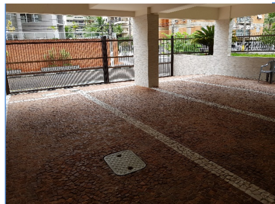
Foto 12 – Vista das garagens no térreo
