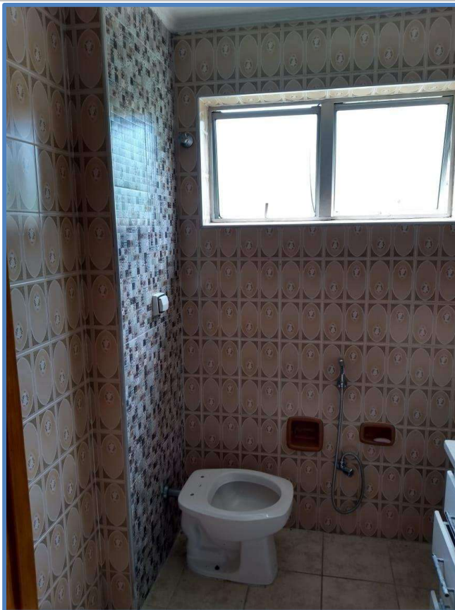
VISTA DO BANHEIRO EXISTENTE NA "SUÍTE".
