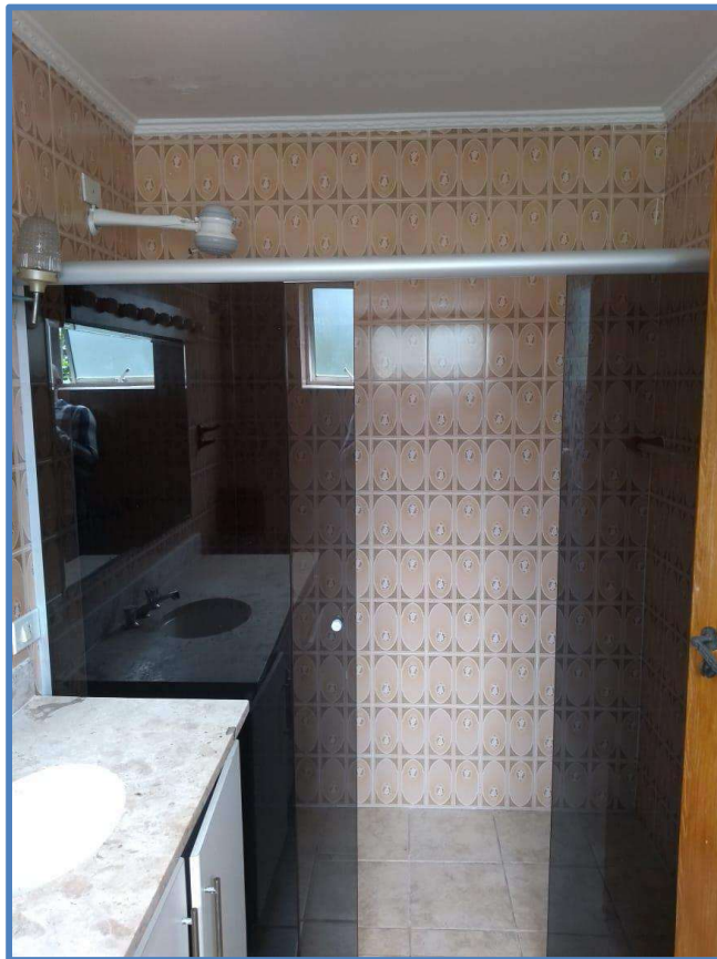
VISTA DO BANHEIRO EXISTENTE NA "SUÍTE".
