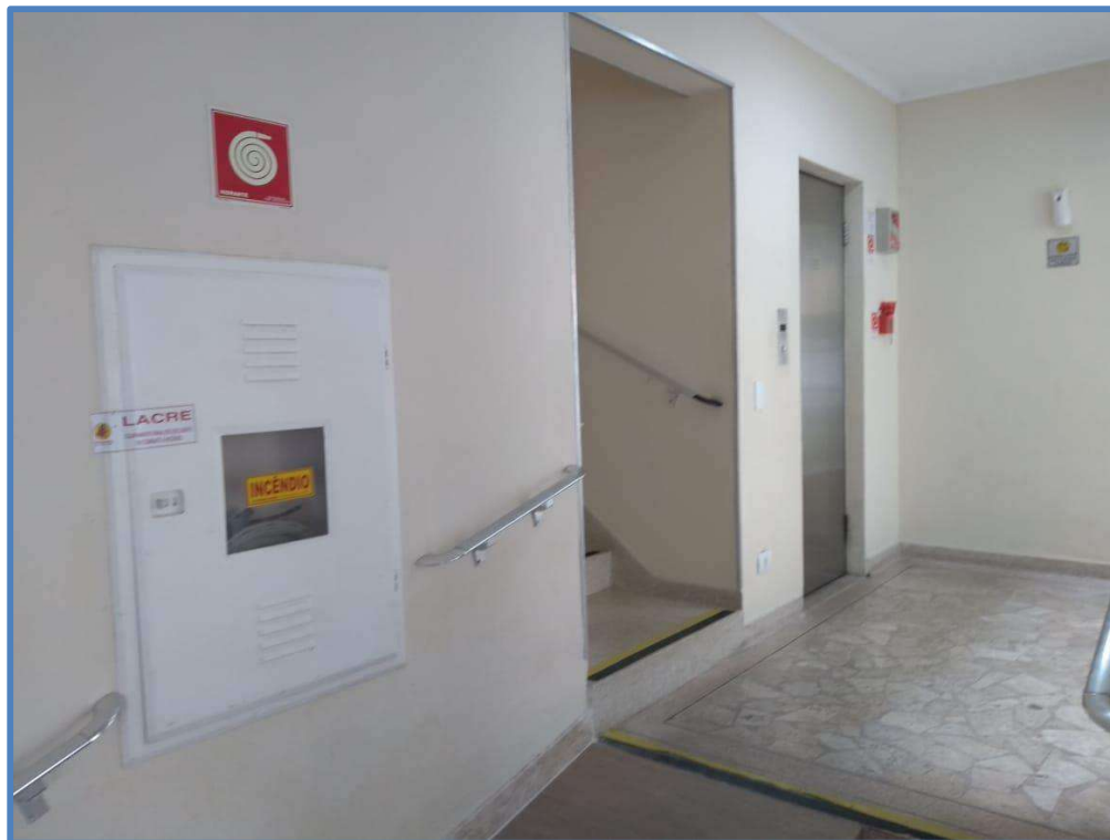
VISTA DO ELEVADOR.
