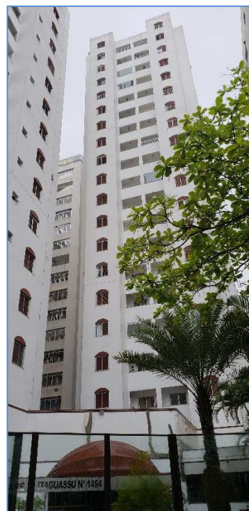
Foto 18– Vista da fachada frontal do edifício
