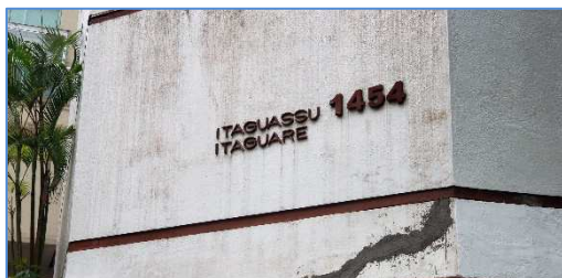
Foto 17 – Vista da fachada frontal
