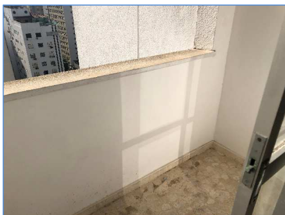
Foto 09 – Vista da varanda da sala
