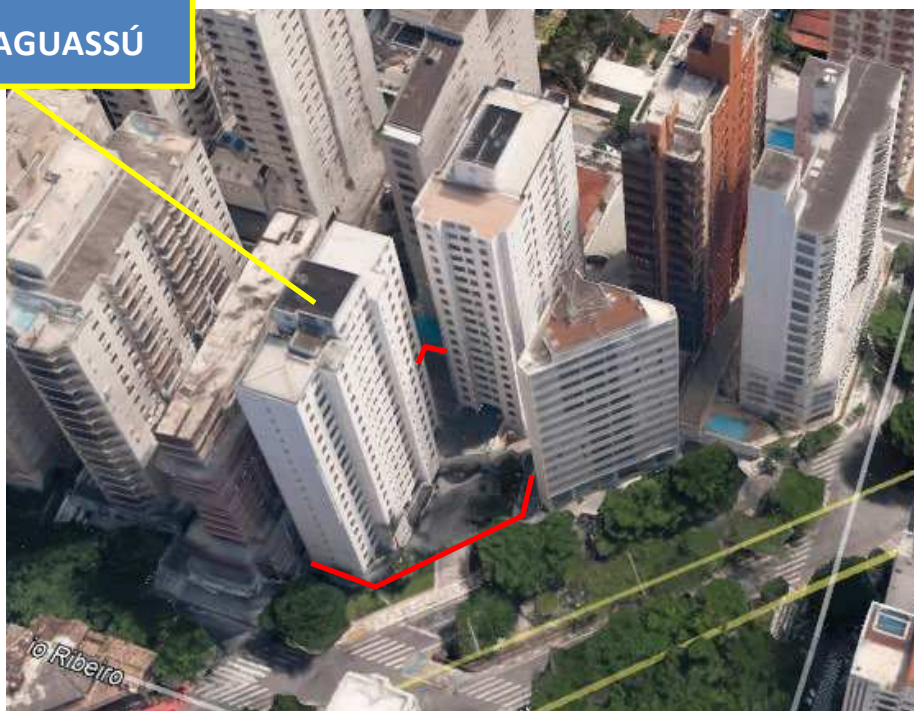
Foto aérea do Edifício Itaguassú, onde está localizado o imóvel avaliando
