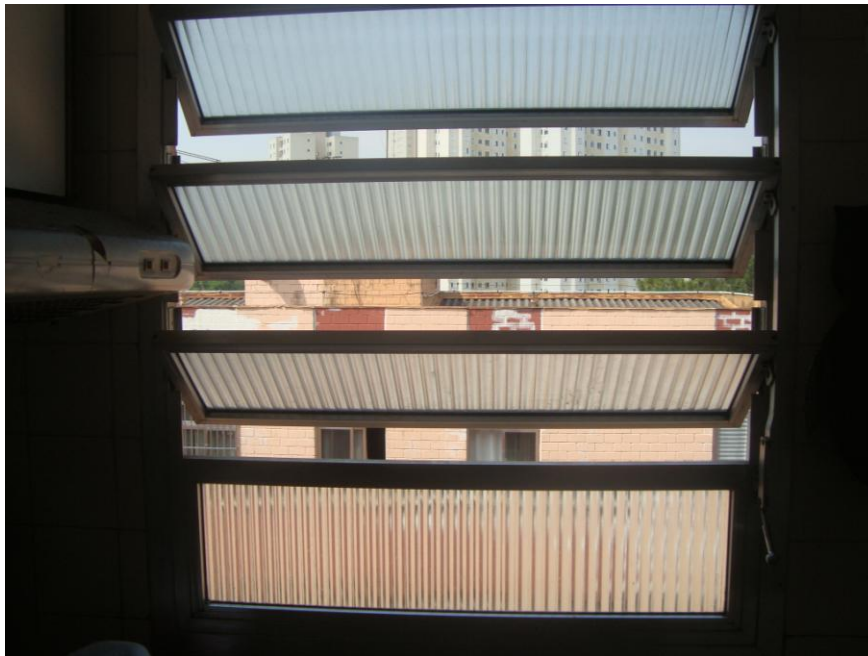
Foto nº 25- Vista parcial da janela da cozinha
