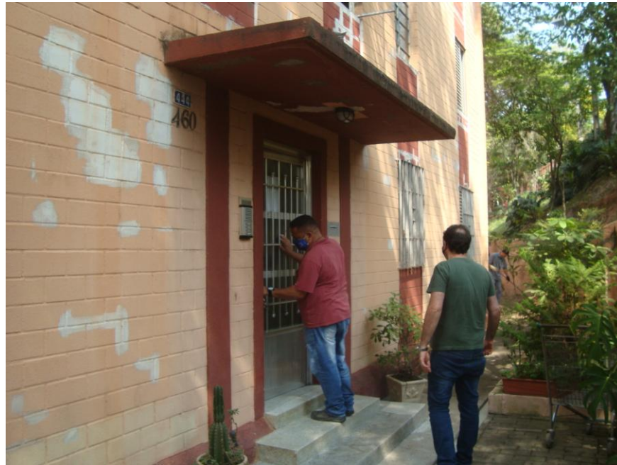
Foto nº 15- Vista parcial da porta de entrada do Edifício Tulipa (Bloco 18)
