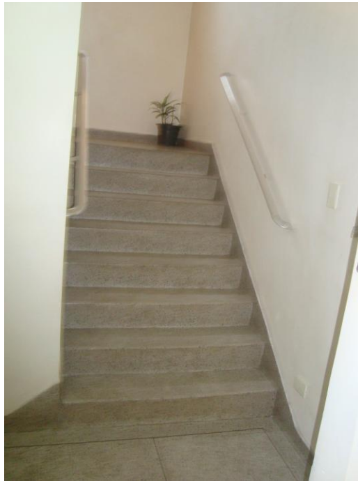
Foto nº 17- Vista parcial da escadaria de acesso aos pavimentos superiores
