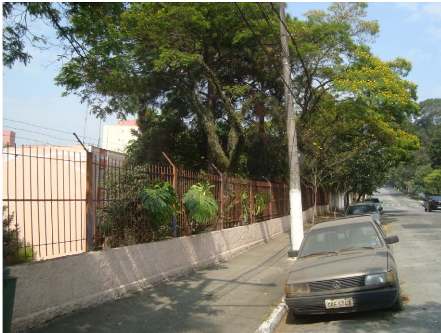
Foto nº 2- Vista parcial da Rua Alcindo Bueno de Assis em frente do condomínio
