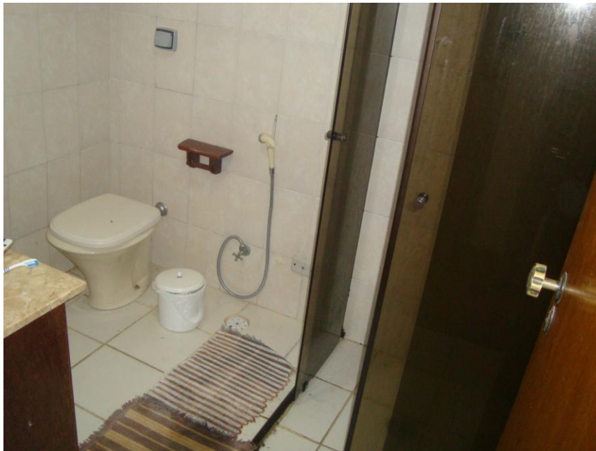
Foto nº 29- Vista parcial do banheiro
