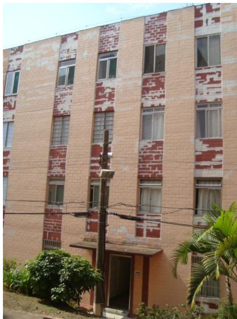
Foto nº 14- Vista parcial de um edifício do condomínio
