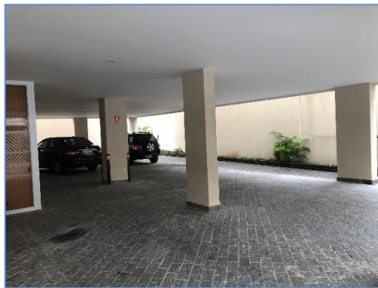
Foto 22 – garagem do terreo
