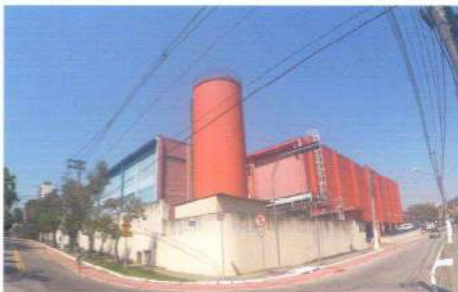
FOTO 06 – Vista da R. Abagiba e R. Alcides Boscolo
